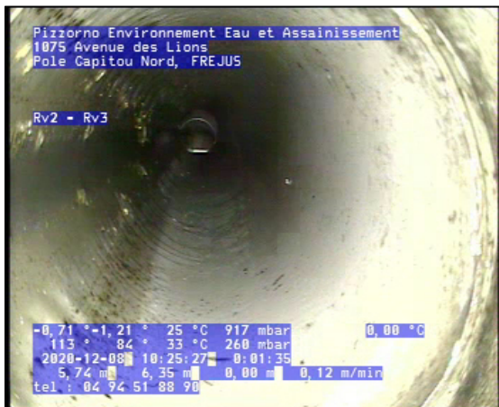
Photo: 2_2_5_B.jpg 5,39m, Culotte, raccordement ouvert à 7 h., hauteur: 125 mm, (largeur: 125 mm)
