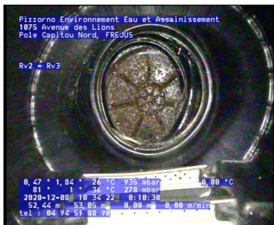
Photo: 2_2_10_A.jpg 52,44m, Noeud d'arrivée, regard de visite Rv3
