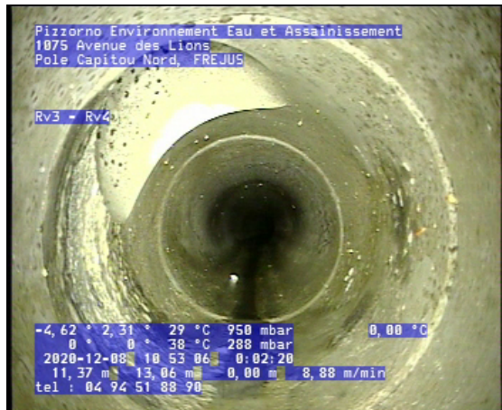
Photo: 3_3_14_A.jpg 11,37m, Culotte, raccordement ouvert à 11 h., hauteur: 125 mm, (largeur: 125 mm)
