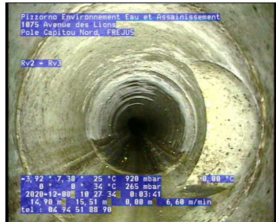
Photo: 2_2_7_A.jpg 14,9m, Culotte, raccordement fermé à 5 h., hauteur: 125 mm, (largeur: 125 mm)
