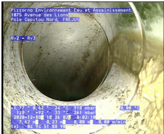
Photo: 2_2_6_B.jpg 7,22m, Culotte, raccordement ouvert à 5 h., hauteur: 125 mm, (largeur: 125 mm)
