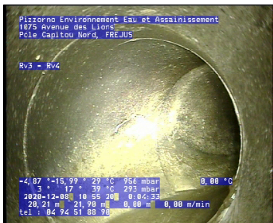
Photo: 3_3_15_A.jpg 20,21m, Courbure du collecteur vers la droite et vers le bas, angle total de déviation: 45 °
