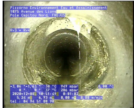
Photo: 3_3_12_A.jpg 5,22m, Culotte, raccordement ouvert à 12 h., hauteur: 125 mm, (largeur: 125 mm)
