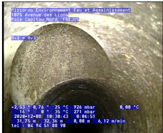
Photo: 2_2_9_A.jpg 31,75m, Culotte, raccordement ouvert à 11 h., hauteur: 125 mm, (largeur: 125 mm)
