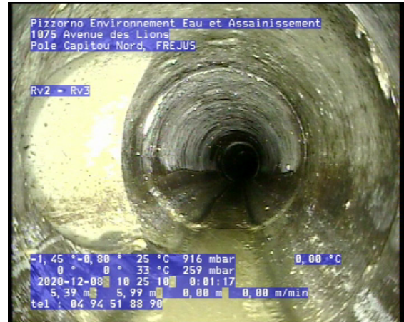
Photo: 2_2_5_A.jpg 5,39m, Culotte, raccordement ouvert à 7 h., hauteur: 125 mm, (largeur: 125 mm)
