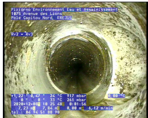
Photo: 2_2_6_A.jpg 7,22m, Culotte, raccordement ouvert à 5 h., hauteur: 125 mm, (largeur: 125 mm)
