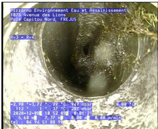
Photo: 3_3_12_B.jpg 5,22m, Culotte, raccordement ouvert à 12 h., hauteur: 125 mm, (largeur: 125 mm)
