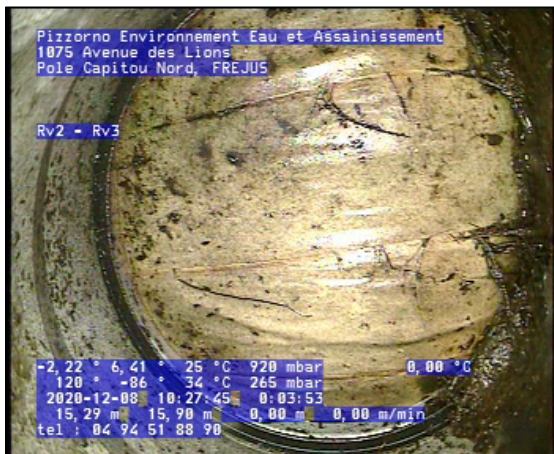
Photo: 2_2_7_B.jpg 14,9m, Culotte, raccordement fermé à 5 h., hauteur: 125 mm, (largeur: 125 mm)
