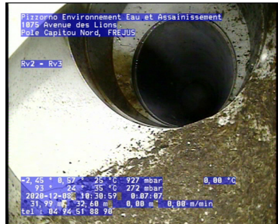
Photo: 2_2_9_B.jpg 31,75m, Culotte, raccordement ouvert à 11 h., hauteur: 125 mm, (largeur: 125 mm)
