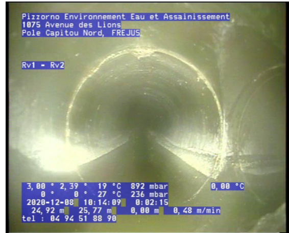
Photo: 1_1_2_A.jpg 24,87m, Culotte, raccordement ouvert à 4 h., hauteur: 125 mm, (largeur: 125 mm)
