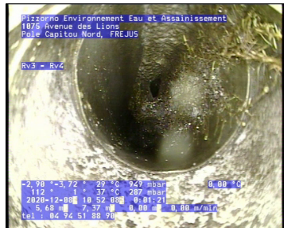
Photo: 3_3_13_A.jpg 5,68m, Grosse racine isolée à 12 h. réduction de la section transversale: 40 %, joint
